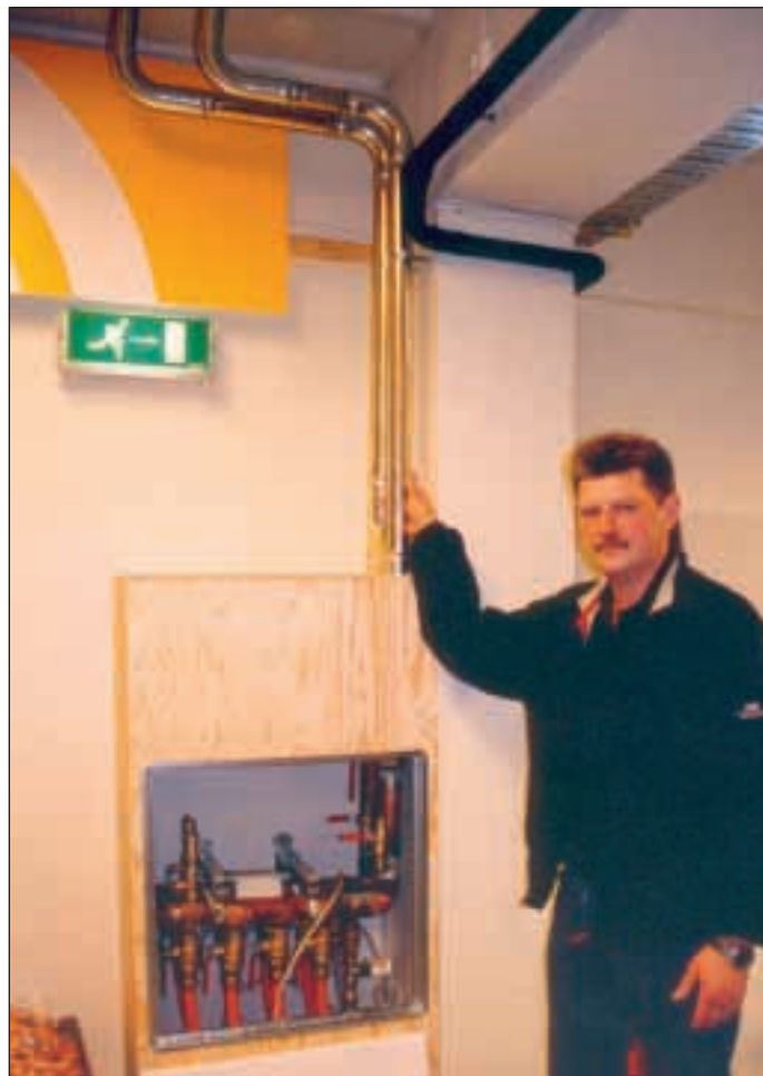
Varme fra kuldeanlegget utnyttes til oppvarming av gaten utenfor butikken, parkeringsplassen og foran varemottaket
