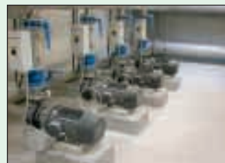
Grundfos NB-pumper i en køleapplikation hos De Danske Spritfabrikker i Grenå
