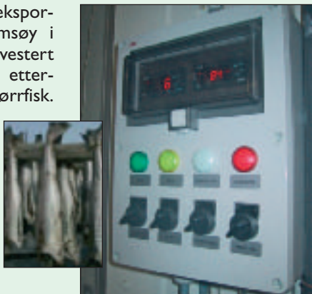
Technoblock styringssentral for klimaanlegg, med brytere og lamper for nedkjøling, oppvarming, befuktning og avfuktning.
