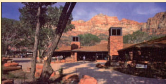
Zion Visitor Center i Utah med de to kjøletårnene og det utvendige utstillingscenteret
