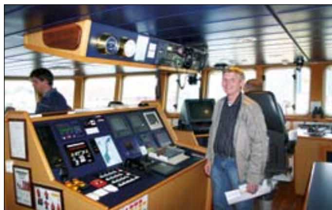
Arild Skar følger med på maskinsjef Kjetil Tuftelands kontroll av alarmutstyret på kompressoren for det 600kW store RSW anlegget.
