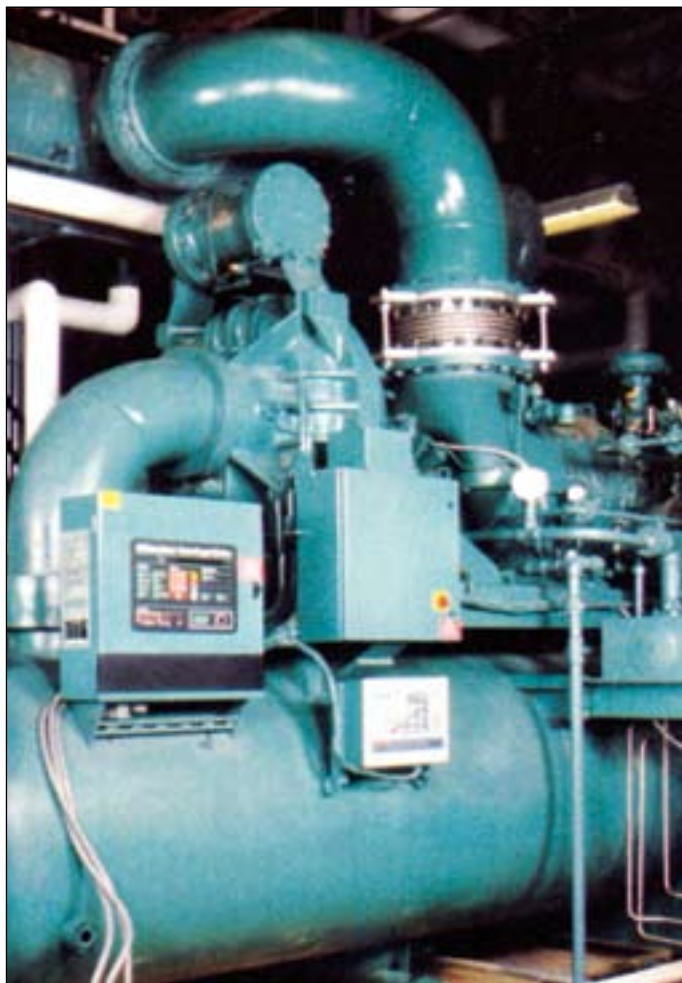
Om strømprisen er skremmende høy og tilgangen på rimelig damp er god, kan dampdrevne kuldeanlegg være et godt alternativ.
