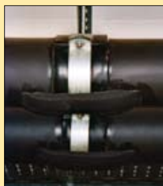
Fig 5: Exempel på en rörskål av styvt PU-skum som ligger an mot elastomerbaserat isoleringsmaterial med en delad stumfog.
