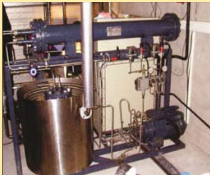
Norges første CO 2 -varmepumpeanlegg installert hos Eggprodukter AS i Larvik med utgangspunkt i teknologi utviklet ved NTNU-SINTEF.
