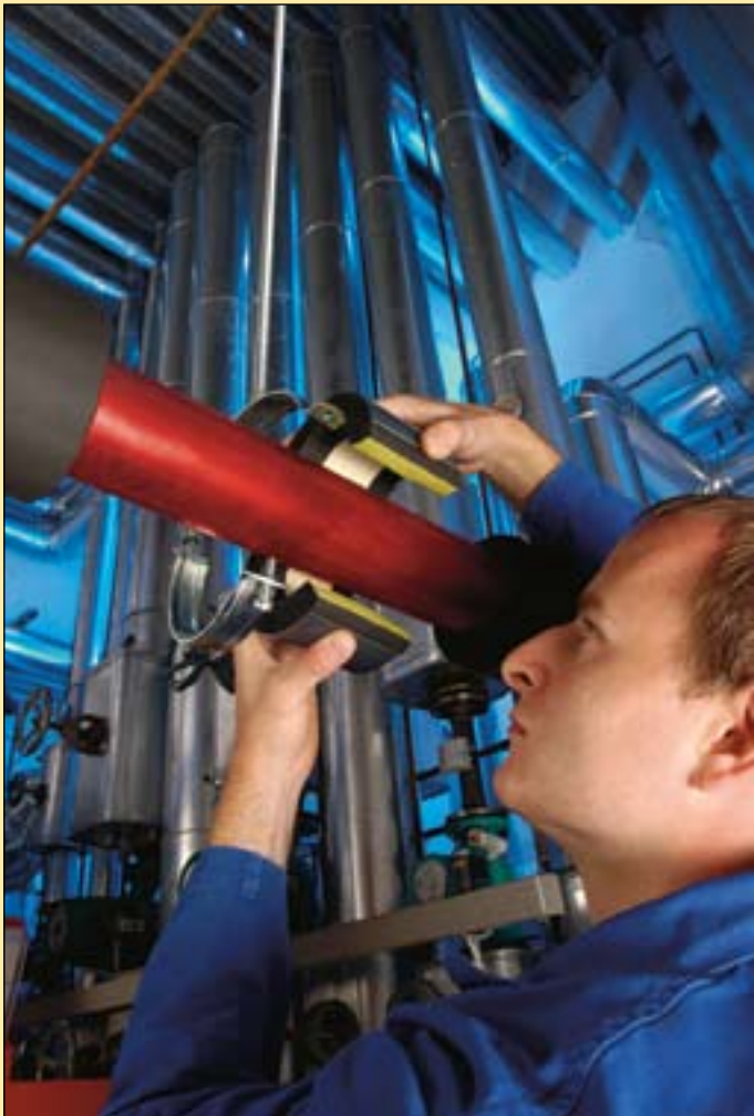
Fig 8: Armafix rörskål installeras i två steg – rörskålen monteras av rörin-stallatören och därefter utför isoleraren den angränsande hopfogningen
