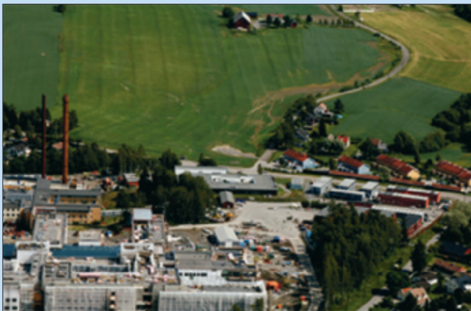
Energi brønnene er boret i et jorde like ved sykehuset. Jorden skal tilbakeføres til landsbruksformål etter at boringen er utført.
