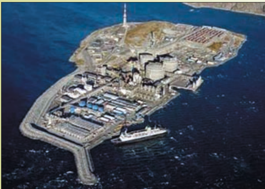
LNG-anlegget på Melkøya ved Hammerfest i oktober 2006.
