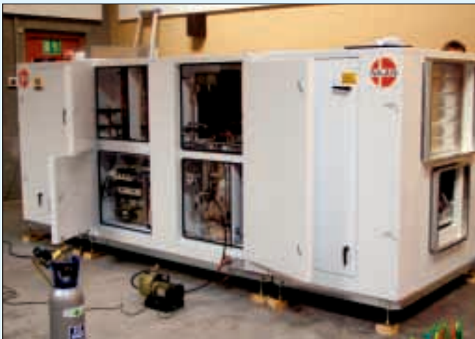
Figur 11: Kaskadeanlæg med CO 2 og propan/NH 3 .
