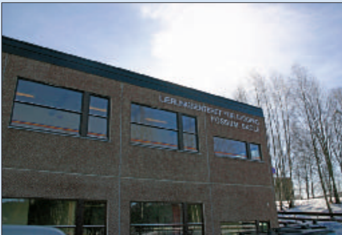
Prøveriggen er plassert i Læringsenteret for Byggfag på Stovner i utkanten av Oslo
