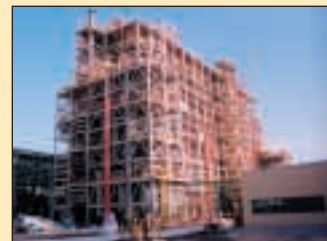
Den nye fabrikk i Louisiana i USA for produksjon av HFC 125, til erstatning for blant annet R22
