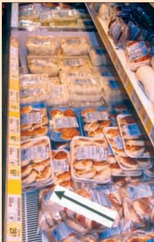
Tildekking av kjølekanalene er heller ikke noe god løsning
