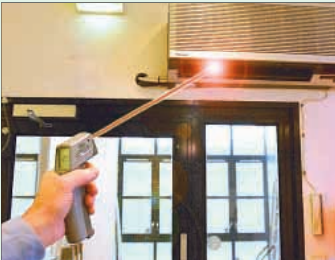
Måling av airconditioninganlegg
