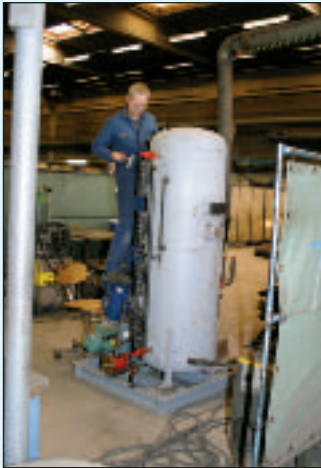
Svenske Lars Erik Tyft fra Sverige arbeider på et nød-pumpningsaggregat.
