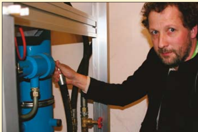
Dag Anders Helle fra Kulde og Energiteknikk AS var imponert over kjøle og fryse anlegget i ICA butikken som ble besøkt. Helle var en av meget få fra den norske kuldeentreprenørbransjen som deltok på konferansen.
