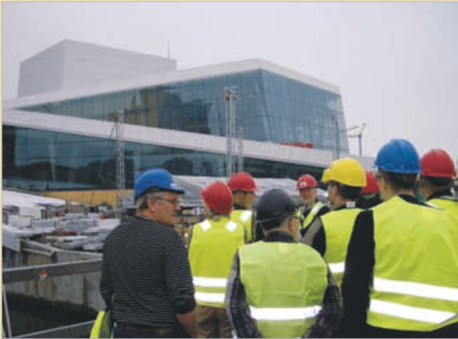
Norsk VVS Teknisk Forening hadde befaring av de tekniske anleggene i den nye operaen under bygging.
