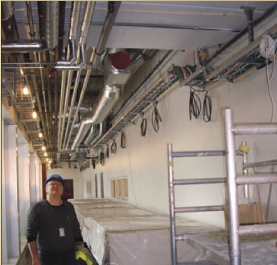
Når elektro, ventilasjon og rør skal frem bli det trangt og mange vanskelige kryssinger.
