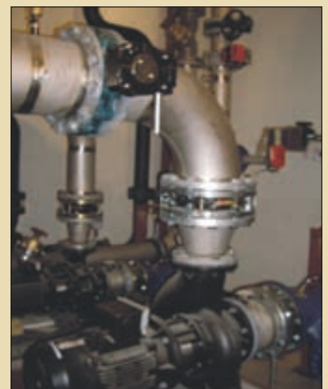
Det var litt for trangt i en del tekniske rom. Her skal vedlikeholdet bli vanskelig.
