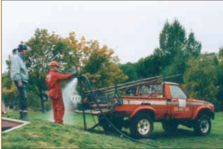
Riggen for trykkingen av brønnen er montert på en liten hendig lastebil. Når boring og trykkingen er foretatt er, er plenen like fin.
