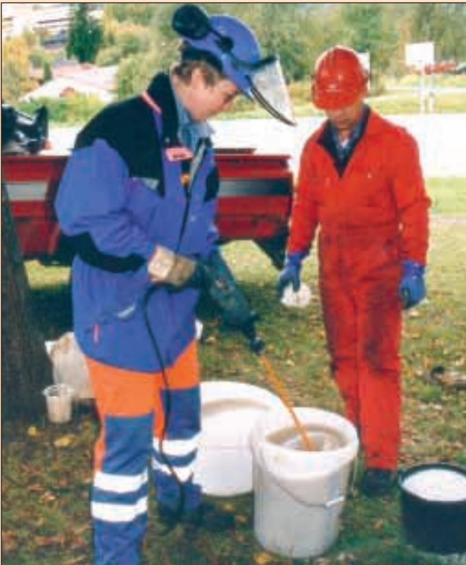
Fortykningsmiddel og kvartssand blandes i en passende blanding og pumpes ned brønnen før trykkingen. Derved oppnår man at kvartssanden føres inn i sprekke fjellet og holder disse åpne
