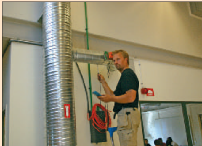
Innreguleringen av ventilasjonsanlegget foretas av Hans Jonson.
