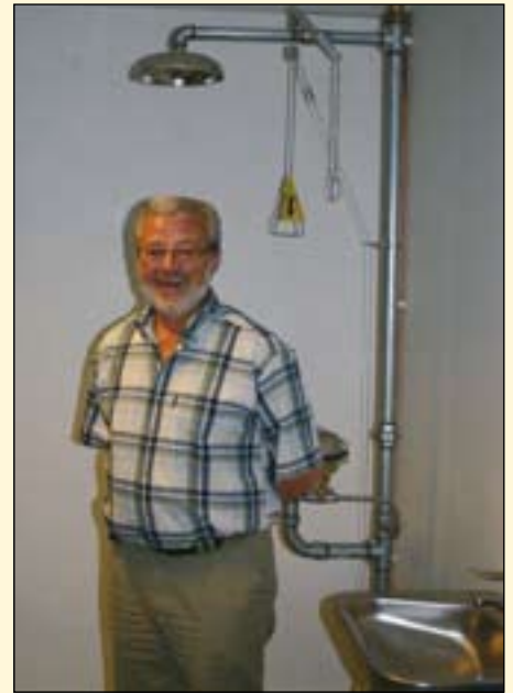
Når man arbeider med ammoniakk bør det aldri være langt til nøddusj og øyevasker.
