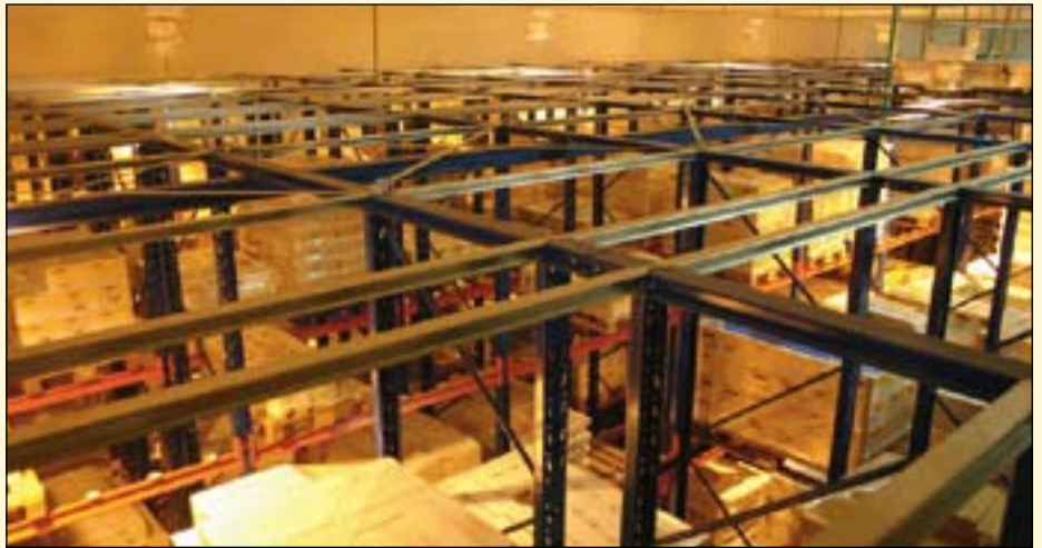
I fryselageret er det meget tørt og lite eller intet rim fordi frysevarerne sluses inn i lageret slik at man ikke slipper inn noe fuktig luft utenfra.
