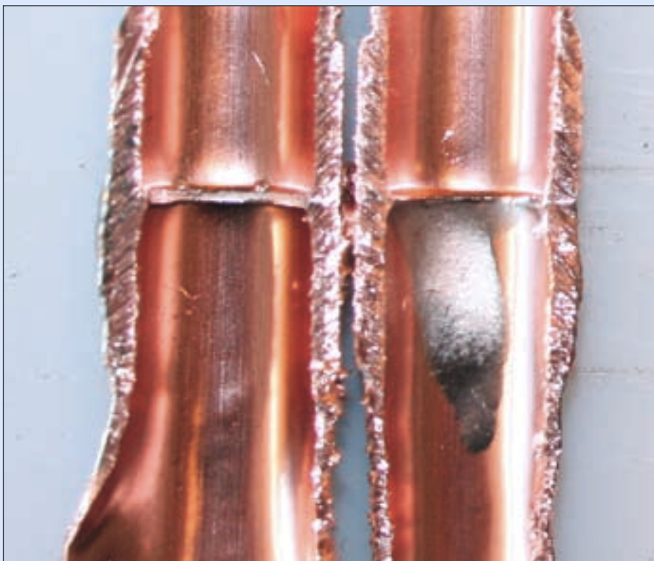
På bildet har en på den ene siden varmet for mye slik at sølvet har lagt seg inne i røret. Det er heller ikke så bra. NB! Som dere kan se er det er benyttet nitrogenfylt rør mens loddingen ble utført.
