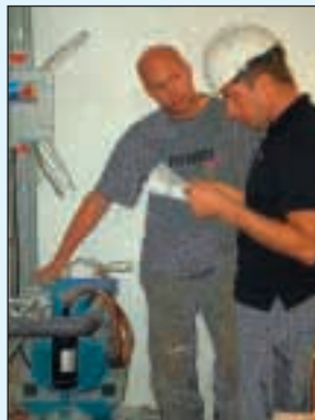
Sivilingeniør kuldeteknikk Morten Solsem (til høyre) bistår elektriker under oppkobling av kjøle- og fryseanlegget ved den nye Høyskolen i Akershus på Kjeller. ABK Kuldeteknikk stod for totalleveranse av kjøle- og fryserom og kjøle- og fryseanlegg.
