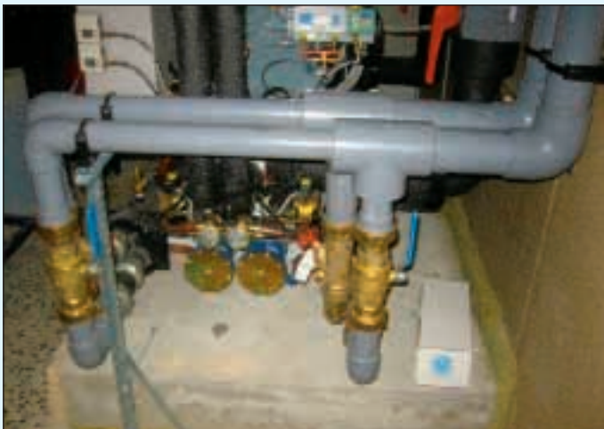
3. Overgang mellom ABS og messing via unioner.
