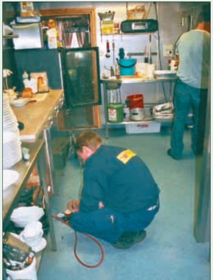
Det er ikke enkelt å komme til kjøleutstyret når det er plassert langt inne under benken i det trange kjøkkenet
