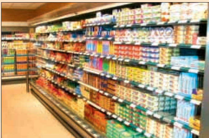
7-plans kjølereol m/etanol og vann basert på nye løsninger med "Norild-Hylla" og "Norild-Henget" for lavt energiforbruk og lave vartemperaturer.
