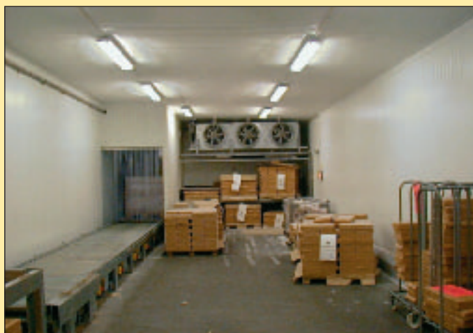
Fryserom før og efter installation af affugtning.
