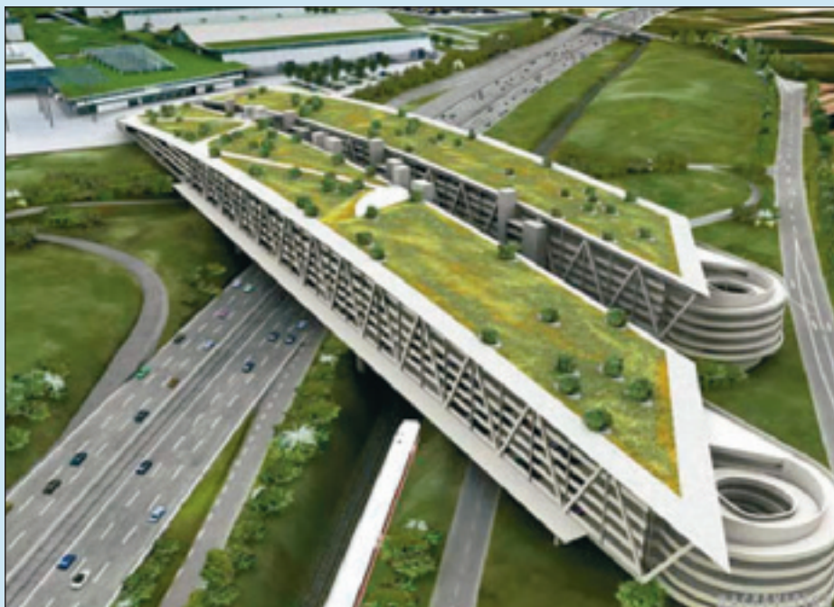
Den nye messen i Stuttgart med det spesielle parkeringshuset som går skrått over Autobahn.
