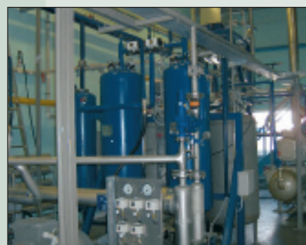
90 % av de bestående kuldeanleggene er modne for rehabilitering
