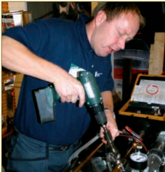
På Johansen demonstrerte den nye metoden for røragreninger under trykk under VVS-DAGENE i oktober
