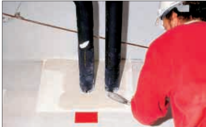
Utførelse av rørgjennomføring fra teknisk rom isolert med Glavaflex celle-gummi og branntettet med FS-GPG tettemasse.
