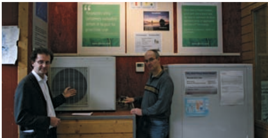
Verdens første luft-vann varmpumpe fra 2001 med CO 2 utviklet ved SINTEF/NTNU. Den er blitt en bestselger i det japansk markedet, for japanerne elsker som kjent kokende bad. Varmepumper av denne typen produseres nå mange 100.000. Petter Neksa og Armin Hafner.
