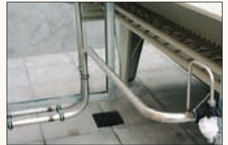
Kondensatorer og røroplegget er av rustfritt stål med 0,7 millimeter veggtykkelse.
