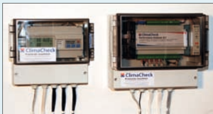
Fast installation av ClimaCheck med Energimätare och modem för on-line övervakning över Internet.
