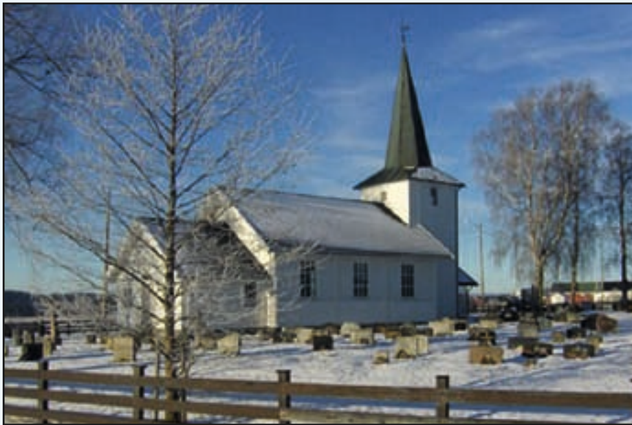
Auli kirke, en liten typisk landsens kirke med stort potensial i arbeidet med å redusere energiforbruket og dermed utslipp av miljøgasser.
