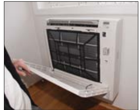
Det er viktig å være oppmerksom på at du enkelt må komme til, for eksempel for å åpne opp, ta ut og rengjøre filteret.
