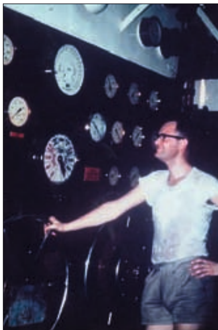
Lars J. Olsen rykket for 45 år siden opp til maskinist og her er han foran manøverpanelet for dampturbinene.
