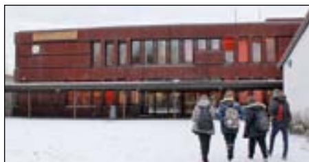
Ringsaker videregående skole i Brumunddal.
