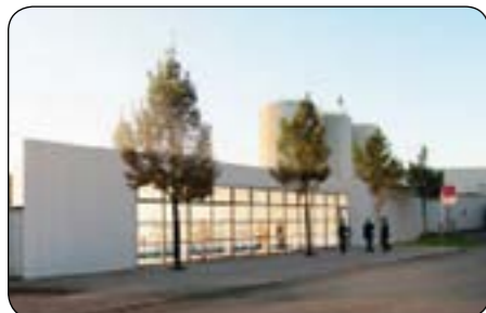
En ny teknik-bygning til varmeværkets varmepumpecentral vil blive opført ved indkørslen til Grundfos' distributionscenter.
