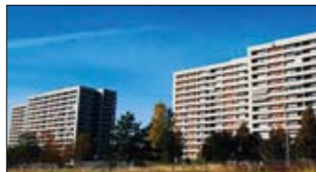
Potensialet for aktive tiltak med varmepumper er klart størst i småhus og boligblokk.
