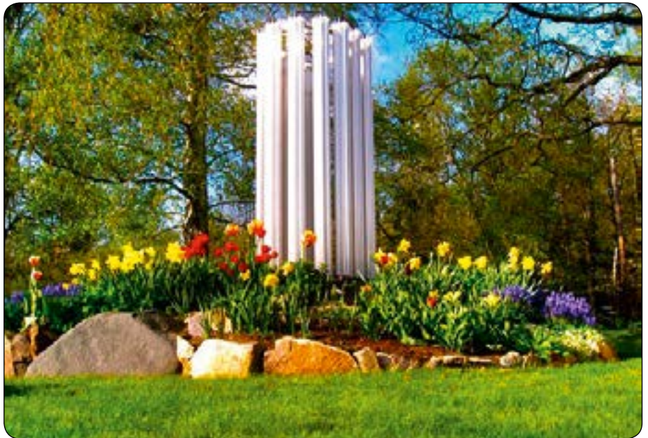
Ispinden er 2.20 m høj og 80 cm i diameter. Denne størrelse kan producere varme til et hus på op til 250-300 m 2 . De lodrette stave er af aluminium og fyldt med propan.
