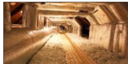
Tilleggsisolasjon av ventilasjonsanlegget på loftet.
