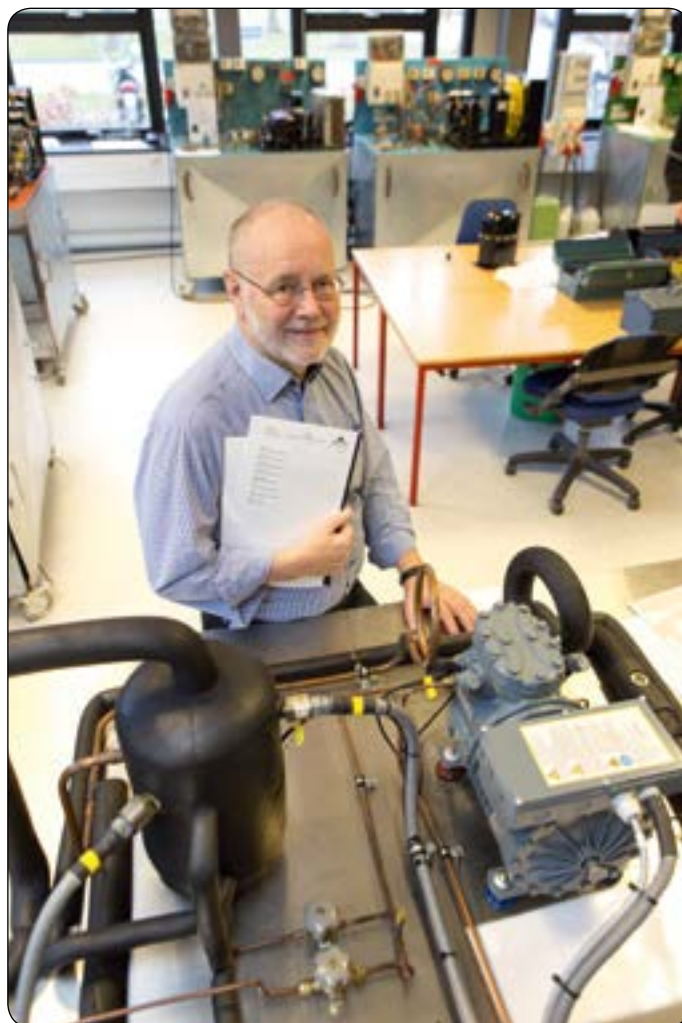
Centerchef Lau Vørs ved Maskinmesterskolen Københavns nye Center for anvendt køleteknik der åbnede 1. December.
