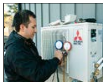
48. Montering av varmepumper
