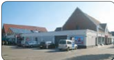
Køle- og fryseanlæggene i Superbrugsen i Skjern sender overskudsvarme ud i Skjern Fjernvarmes ledningsnet. I alt kommer brugsen til at producere 20 almindelige huses årsforbrug af fjernvarme.
