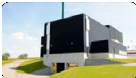
Med en ny varmepumpe sparer Hurup Varmeværk nu 9 pct. af flis-brændselet.
