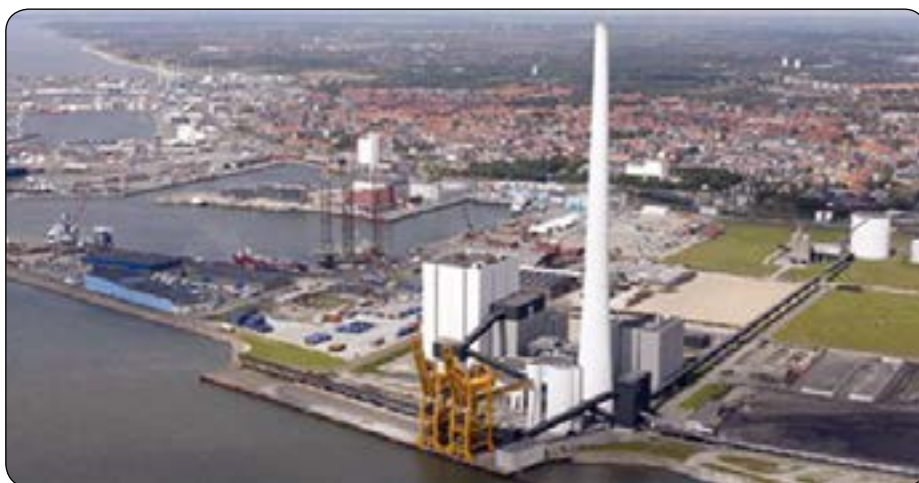
Esbjergværket i Esbjerg benytter primært kul til produktion af el og fjernvarme. Men for eksempel i Drammen i Norge man har en 13-MW-varmepumpe, der bruger havvand som varmekilde ved 8-4 grader Celsius og giver en COP på over 3.
