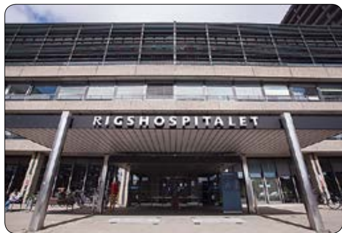
Grundet stort kølebehov på OPS-intensivstuer på Rigshospitalet, samt trækgener for patienter og personale, søgte Rigshospitalet nye muligheder for ventilationsløsningen.
