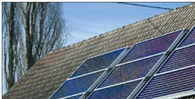
Solfangere på norske tak for oppvarming i vinterhalvåret. Men kan de ikke også benyttes til adsorpsjonskjøling om sommeren når vi har mest sol og varme?
