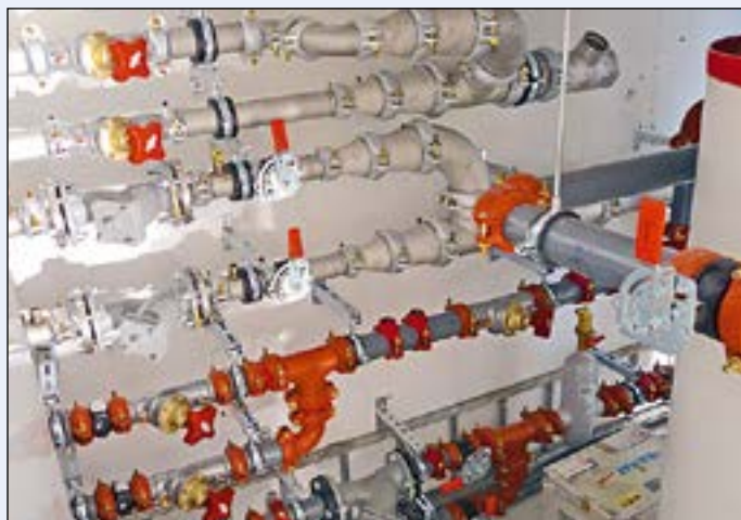
Enkel montasje av rørkupling med to bolter. - Systemet er svært hurtig og sikkert, det finnes i dag komponenter og løsninger for det meste av rørtyper, som bend, T-rør, ventiler og koblinger.
