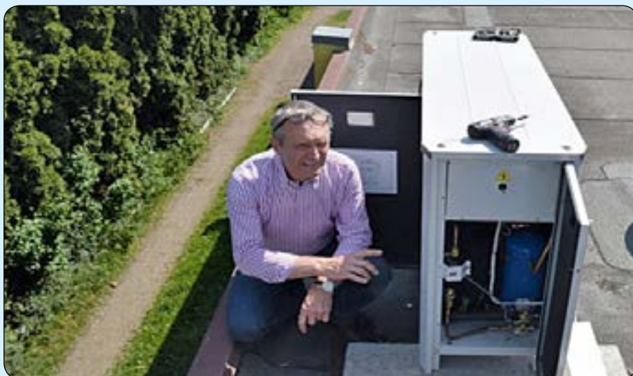
Figur 3 Servicen blir enkel for kondens enheten har tre dører og micro channel varmeveksler.
