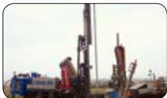
76 19 fynske parcelhuse får felles energibrønd
