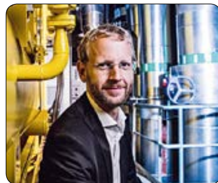
På billedet ses chef for HOFOR Fjernkøling A/S, Henrik Lorentsen Bøgeskov, foran en gul 5 MW kølemaskine, der bruger havvand om sommeren til at afkøle maskinen.
