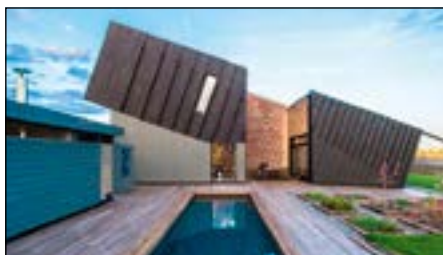
På Brødrene Dahls unik kompetansesenter har man et hus hvor hele taket er dekket med 147m 2 solcellepaneler, noe som gjør huset til og med et plussus.
