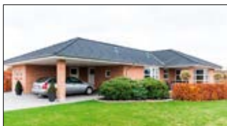
Selve installasjonen av varmepumper ble vesentlig billigere da brønnene ble boret før salget av tomtene.
