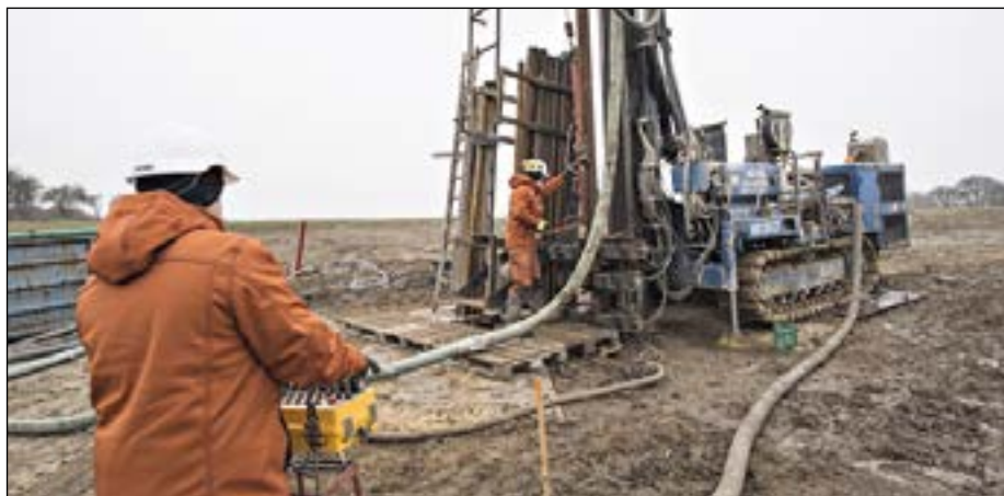
Kommunen boret brønner for jordvarme, før de nye hustomtene ble lagt ut til salg.
