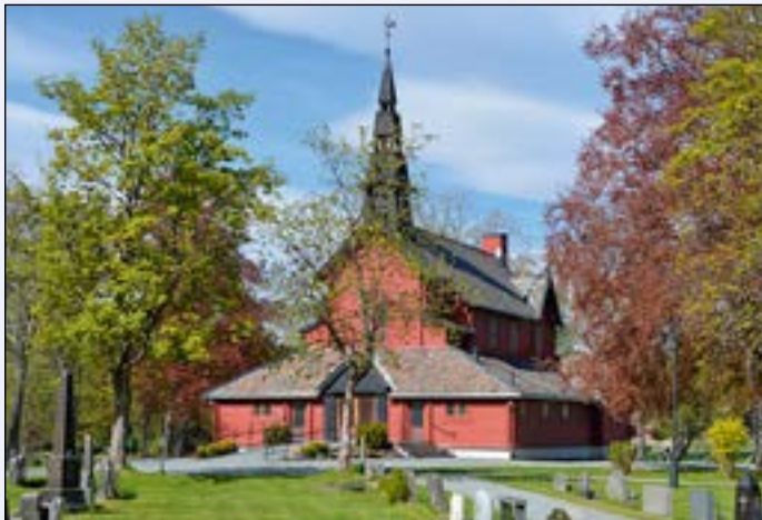
Tilfredshet kapell med nytt varmeanlegg med R-410A luft/vann varmepumpe.
