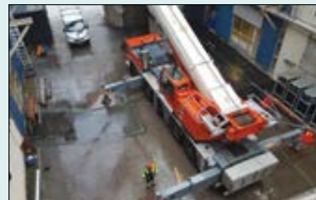
Det var særlig spennende da den massive kranen må stå trangt til og med kjellere under. Nøyaktig plassering av støttebein var viktig her.
