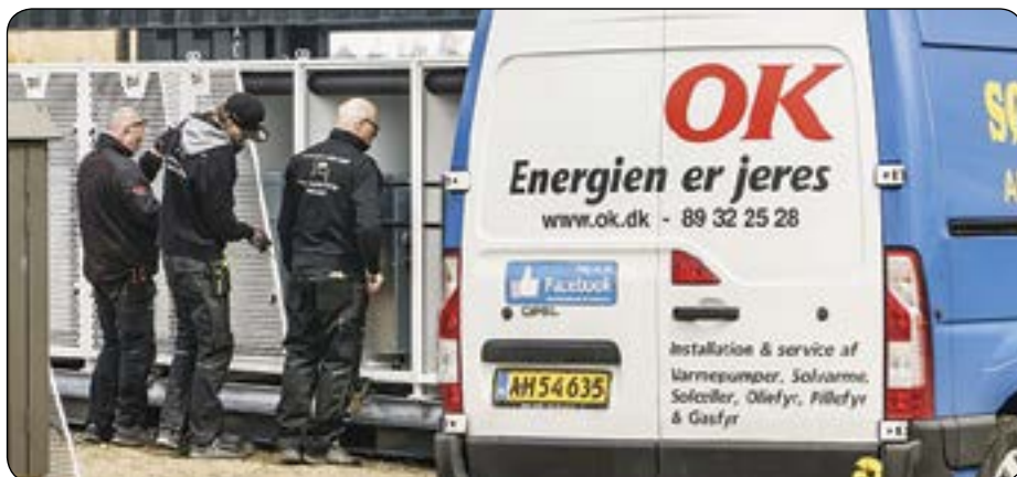
OK har fået del i Energistyrelsens støtteordning, der skal fremme udbredelsen af varmepumper til virksomheder. Foto: OK/Steen Knarberg.
