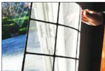
Filterne i varmpumpa bør rengjøres en gang i måneden. Oftere hvis du har husdyr.
