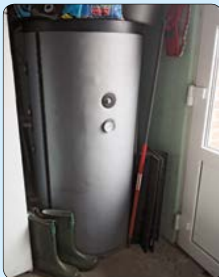
Varmtvandsbeholderen, der opsamler varme fra solfangerne på taget, skal også indgå som en del af familien Rohdins nye Suntherm Smartheat varmeanlæg.
