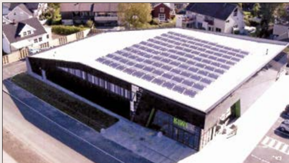
560 m 2 solceller på taket
