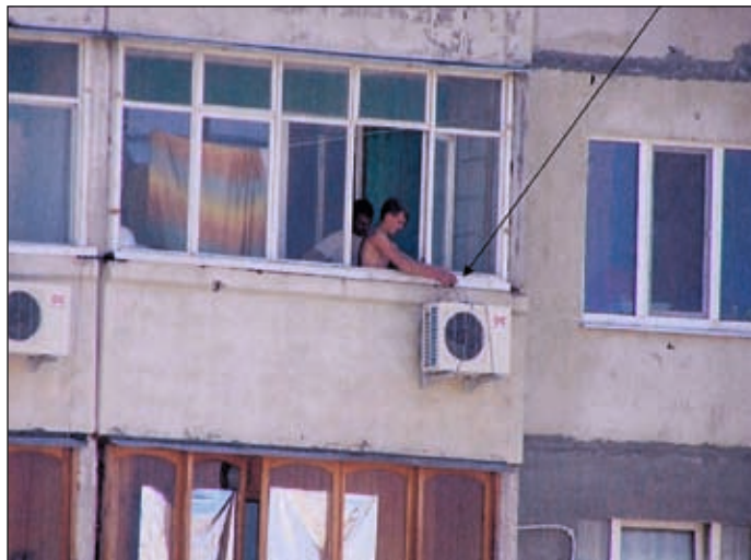
Så heises utedelen på plass med tau. Det er praktisk med to mann på jobben.
