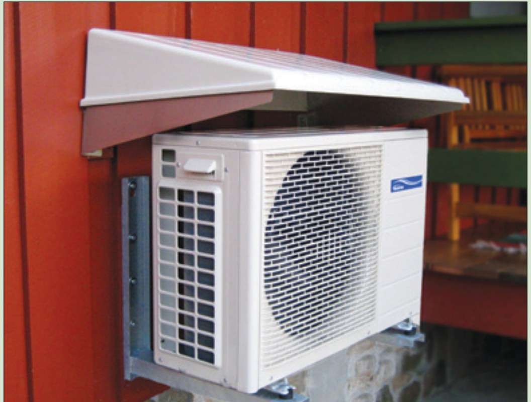
Utedelen bør ikke stå for langt fra innedelen, være skjermet mot regn, ha god lufting og god drenering slik at vann ikke renner ned langs grunnmuren. Den bør plasseres godt over bakken for å hindre nedsnøing og man må ta hensyn til vibrasjon og lyd fra varmepumpen.
