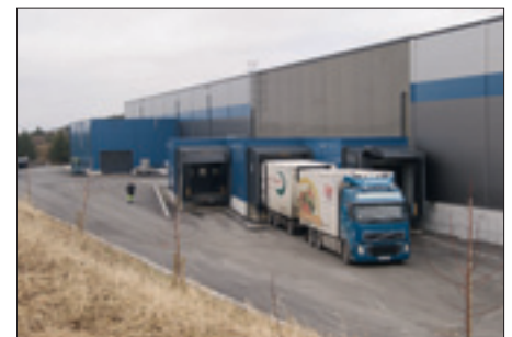
Permanor har egen oppstillingsplass med strømuttak for frysecontainere.
