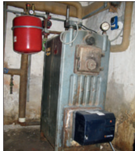
Den oliefyr er klart helt overmoden for udskiftning.
