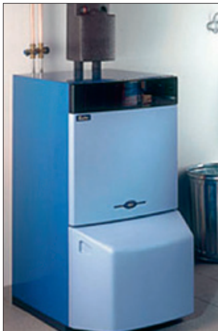
Det er meningsløst å skrotte en slik moderne oliefyr når den med fordel kan benyttes til spidslast for varmepumper.
