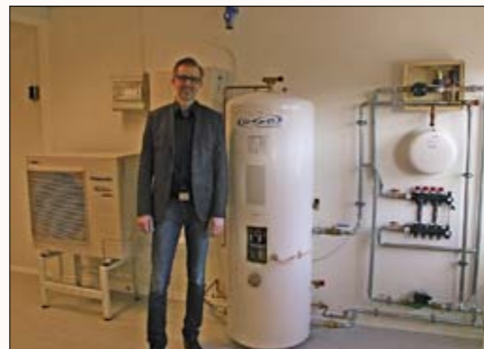
Richard Sundet er leder for de kursene man jevnlig avholder i egne lokaler for egne distributører. På bildet ser man en "utbredt" luft-vann varmepumpe for opplæring.
