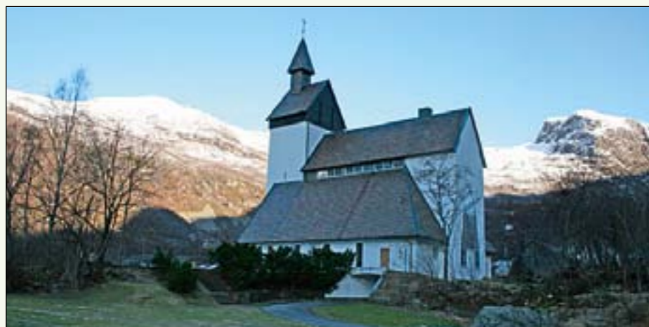
Vakre Høyanger kyrkje vart bygd i 1960. Arkitektar var Arnstein Arneberg og Olav Platou, og byggmeister Leidulf Fosshem.
