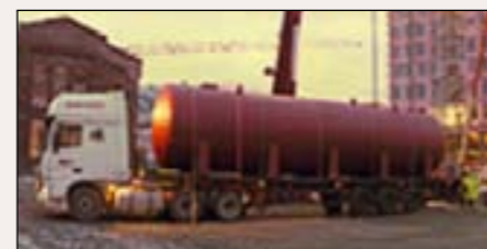
Kuldelagringsstankene ankommer byggeplassen.
