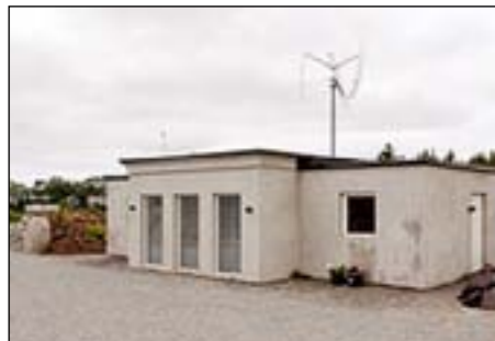
Målinger av energiegenskapene til polybetong videreføres i dette prøvehuset i Pålakrossen i Klepp kommune. (Foto: Polybo AS)
