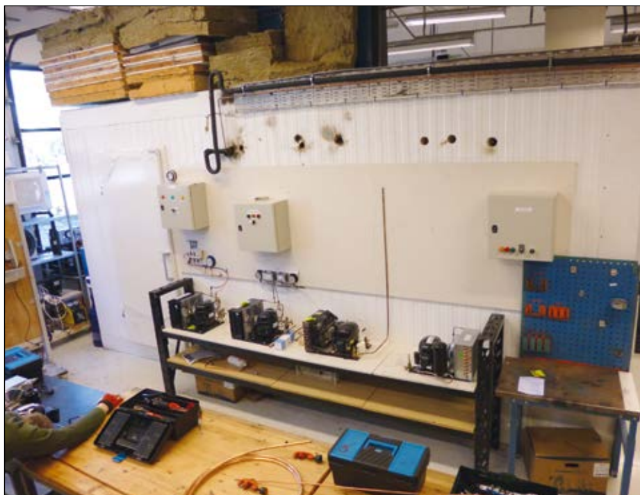
Verkstedet på Godalen vgs.
