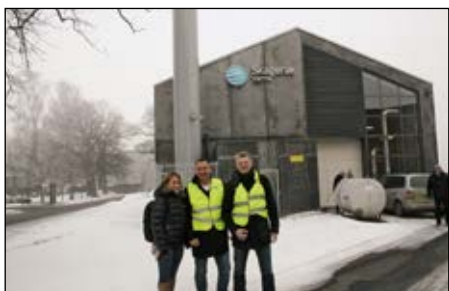
Skagerak Energis nye varmesentral i Horten med sjøvannsvarmepumper og gasskjeler åpnes offisielt 8.mai. Til høyre avdelingsleder Ulf Larsen i EPTEC Energi og to av deltakerne.
