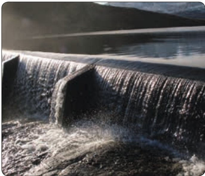
Vandkraftværket Buksefjorden ved Nuuk. Billedet tilhører Nukissiorfiit.
