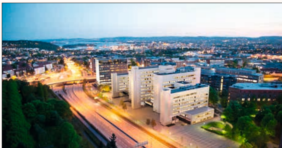
Økt fokus på klimautfordringene har ført til at vi i dag bygger med stadig bedre energistandarder.
