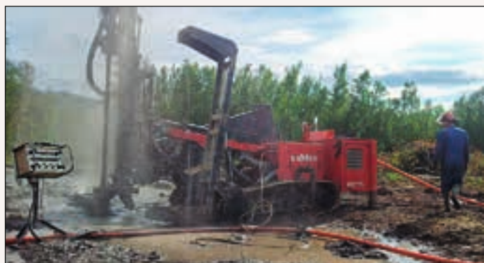
Man kan bore helt ned til ca. 250 meter på energibrønner.
