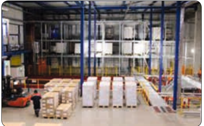
I byen Rheine i Nordvesttyskland opførte firmaet KLM Logistic i 2013 Tysklands første, største og højeste fuldautomatiserede frostlager. Munters affugtning muliggør problemfri drift.
