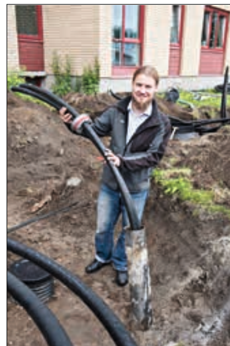
Det er boret 14 brønnparker fra 4 til 15 brønner på mellom 250-300 meter.
