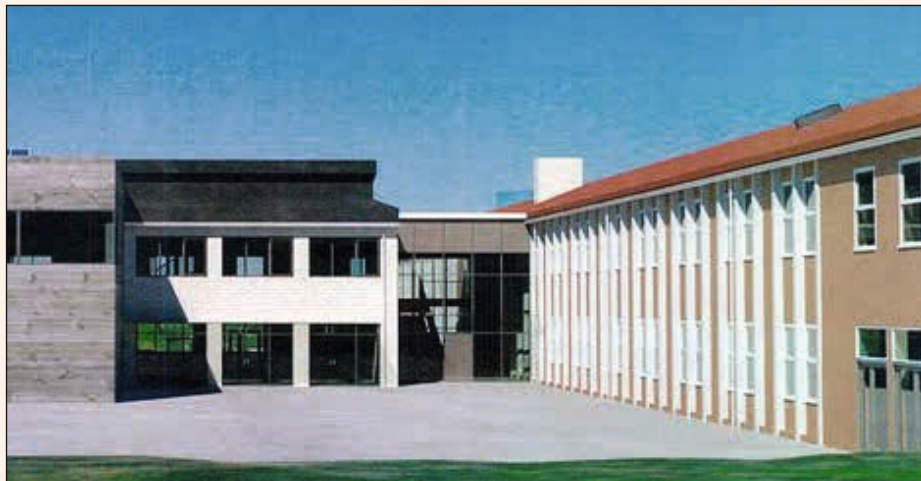
Varden skole i Fyllingsdalen i Bergen skal oppgraderes med PVT-paneler og grunnvarmepumpe. I tillegg rives deler av skolen, og erstattes med passivhus. Foto: Sweco.
