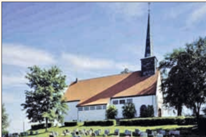
Fig. 1 Ranheim kirke. Denne har nå vann-vann R-134a varmepumpe og 3 stk energibrønner. Den holdes på hviletemperatur når den ikke brukes.
