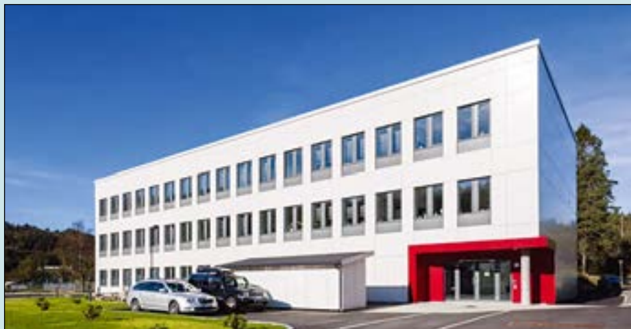
Forsvarets administrasjonsbygg på Håkonsvern bruker kun imponerende 17,1 kilowattimer pr. år pr. kvadratmeter.
