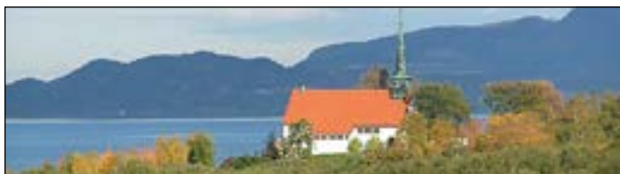
Med den nye varmpumpen går energiforbruket fra 207 til 90 kWh/år/m 2 i Ranheim kirke.
