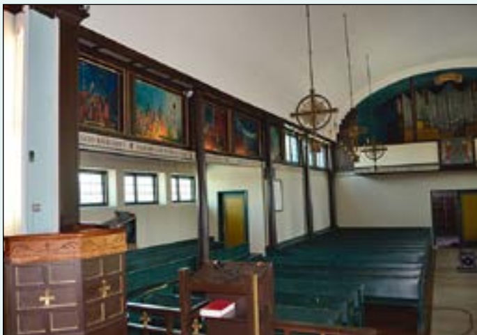
Interiør i Ranheim kirke. Det ble bygget i 1932, murt i teglstein og pusset. Areal 330 m 2 . Opprinnelig var den oppvarmet med oljefyrt steamkjel (!)
