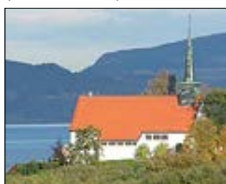
28 Varmepumpeanlegget i Ranheim kirke
