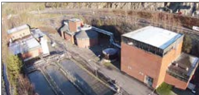
På Nordre Follo Renseanlegg blir biogass fra slam brukt til å produsere elektrisitet. Foto: På Nordre Follo Renseanlegg IKS
