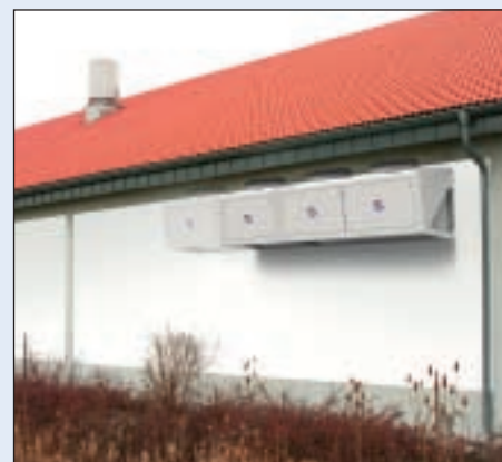
Den nyutviklede varmeveksleren Microox med mikrokanaler i aluminium.
