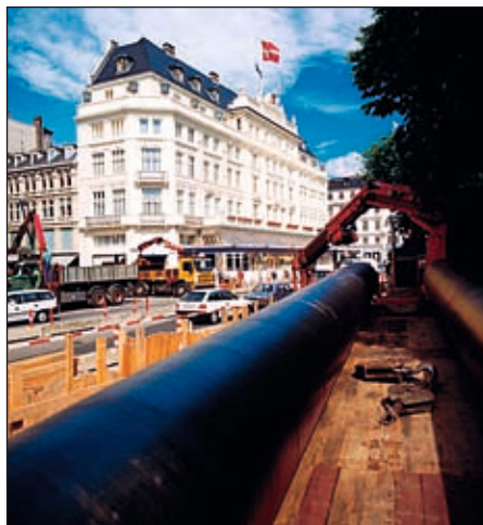
Det indre København er et af de sværeste steder at grave rør til fjernkøling ned, både fordi der er så ufremkommeligt, og fordi rørene er så store.
