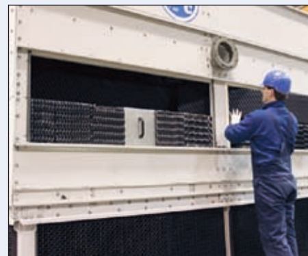
Fig. 3: Demonterbare sidepaneler og kjøletårnsinsats.
