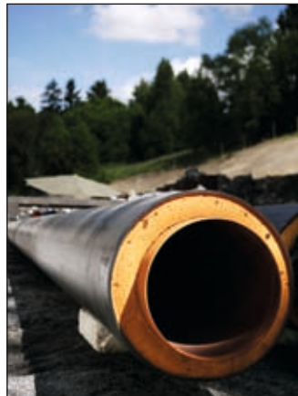
14. Varmepumper tar marked fra fjernvarme
