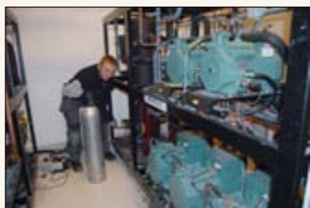
Montering av CO 2 -kompressorene ved Espen Edvardsen.
