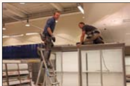
Montering av kuldereoler i COOP i City Nord i Bodø utført av Espen Edvardsen og Stein Egil Helskog.
