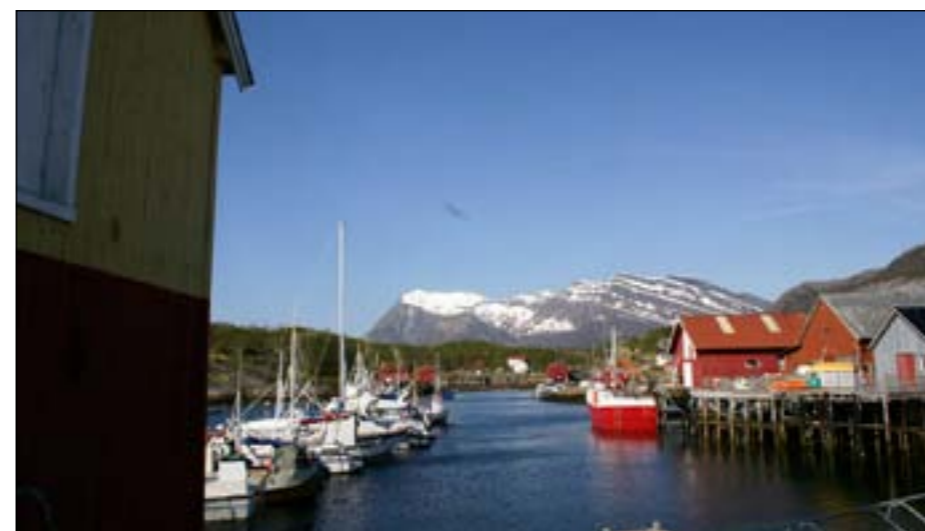
Svært mange av fjernvarmeanleggene ligger i nærheten av sjø, vann eller elv og da har man gode muligheter til energisparing ved å bruke av varmepumper drevet med fornybar elektrisk kraft.
