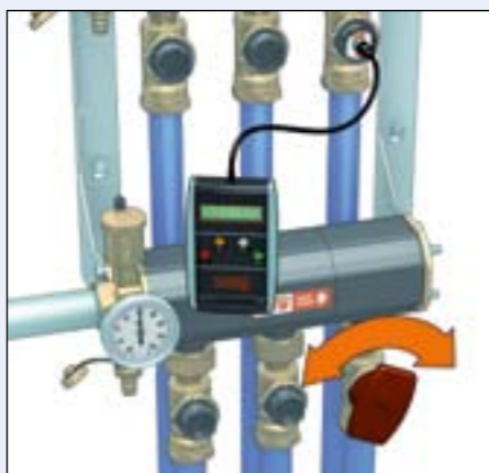
Samlestock med innregulering vha elektronisk måleenhet.
