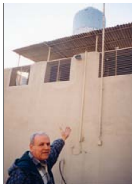
Driftsingeniør Mohamed Abdul Motelb viser hvordan man åpnet sideveggene på taket med kanaler rett inn til kondensatorene.
