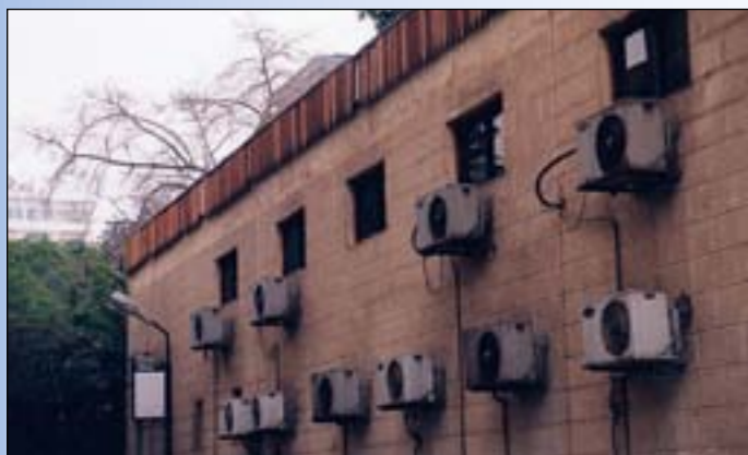
Et felles kjøleanlegg hadde vært mye mer rasjonelt og energibesparende og dessuten hadde fasadene blitt vesentlig penere.
