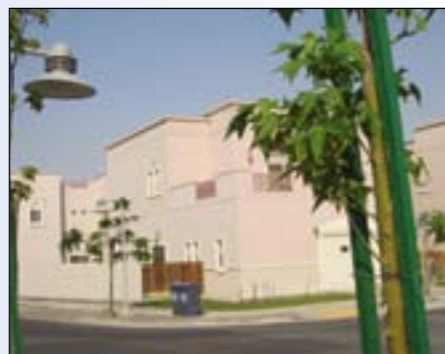
Små vinduer med dobbelt glass, tykke terrakotta vegger og innvendige takhøyder opp i 5 meter og kjøleanlegg gjør boligene svært behagelige også om sommeren. For da er man stort sett inne.
