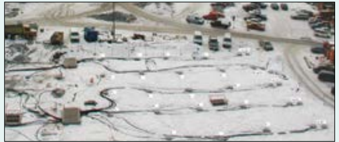
Arrangement av Avantor sin brønnpark før den ble fylt over og bygget parkeringshus over.
