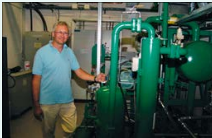
Artikkelforfatteren ved høytemperaturvarmepumpen på Institutt for Energiteknikk på Kjeller som bruker spillvarme fra forskningsreaktoren som varmekilde.
