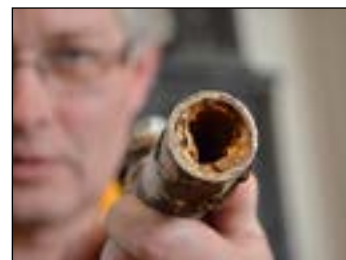
28. Husk å rense røranlegget
