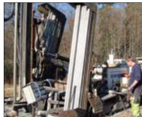
Båsum Boring i gang med grunnundersøkelser for bergvarme til den nye amerikanske ambassaden i Oslo.
