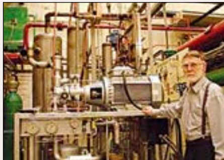
Professor Einar Brendeng har utviklet små kondensasjonsanlegg for naturgass basert på standardutstyr. Her er han i gang i laboratoriet med innkjøringen av det nyutviklede kondensasjonsanlegget.
