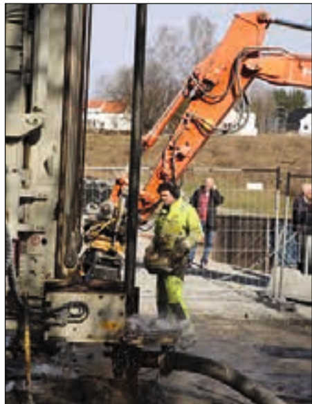
Vannspruten står når Båsum Boring borer 800 meter dyp energibrønn i Asker.
