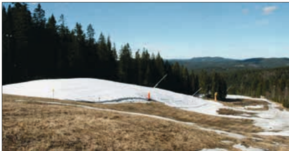
Snøhaugen på 12.000 kubikkmeter ved Tryvann i Oslo er dekket med en 3500kvadratmeter hvit duk som reflekterer varmen. Til høsten håper man å ha beholdt 6.000 kubikkmeter for en tidlig start på sesongen.
