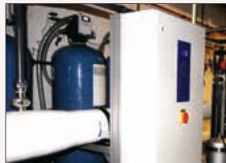
Kjent teknologi, men satt sammen spesielt for å få rent vann til skøyteisen.
