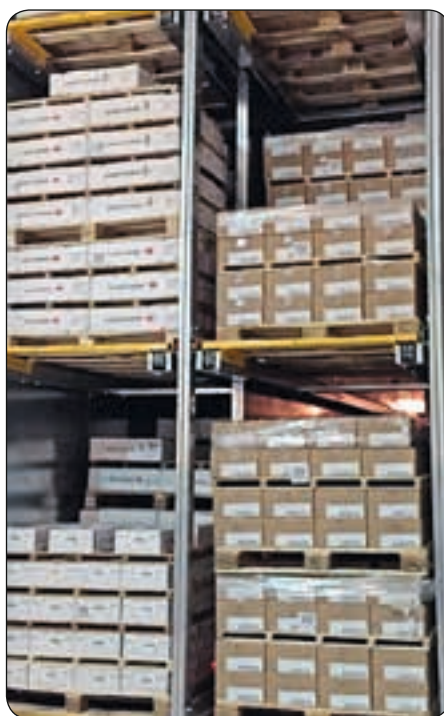
Opbygningen af eksisterende fryse-tunneller er langt fra optimal med hensyn til energieffektivitet og hurtig indfrysning.
