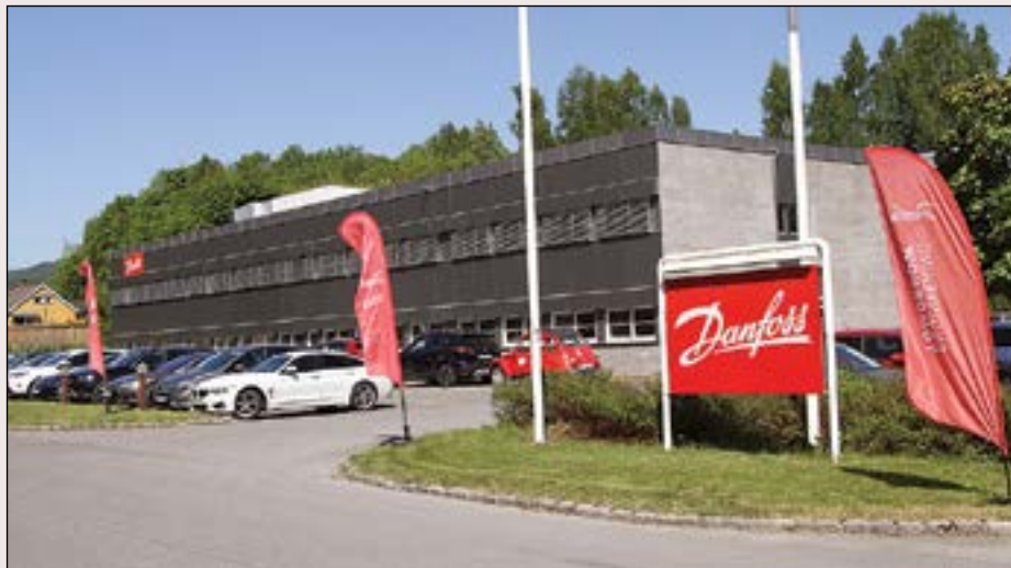
Danfoss gamle hus på Skui er fullstendig ombygget og påbygget og man har fått et meget moderne bygg med effektive og delikate arbeidsplasser.
