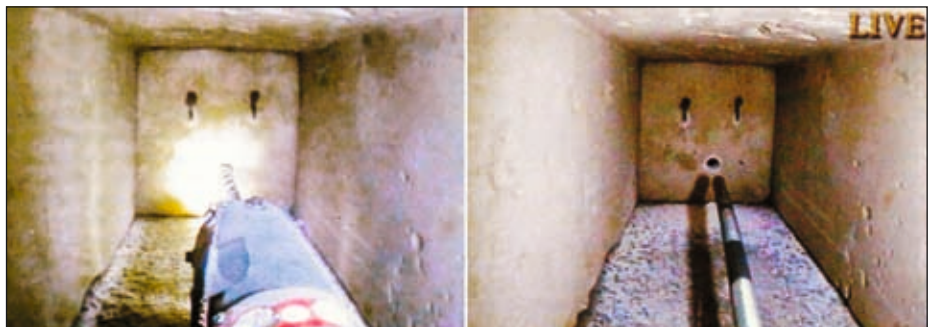
Den lille døren i en av sjaktene. Bildet til venstre viser boringen av et 30 med mer hull i døren. På bildet til høyre fører man et spesialutviklet kamera gjennom døren. For å ta en titt på baksiden hvor man bare oppdaget en ny dør. Hva som skjuler seg bak denne vet man ennå ikke.
