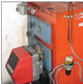
35 Vannbåren varme - for dyrt i Norge?
