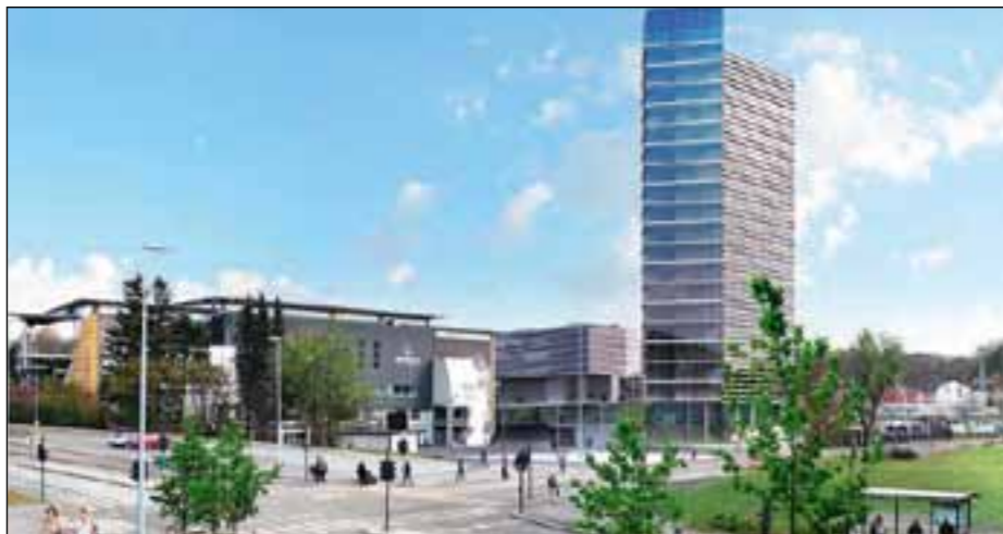
Ved hjelp av hypermoderne teknologiske løsninger vil det nye høyhotellet på 75 meter på Lerkendal bli verdens mest energieffektive. Hotellet skal bruke mindre enn en firedel av energikravene til hoteller i Trondheims klima.
