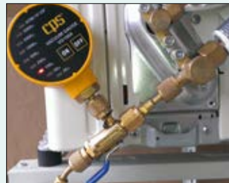
Bildet til venstre viser pågående vakuumering med åpen ventil. Til høyre (holdetid) er ventilen stengt, og antall forbindelser mellom vakuummeter og kuldeanlegg er redusert til et minimum.
