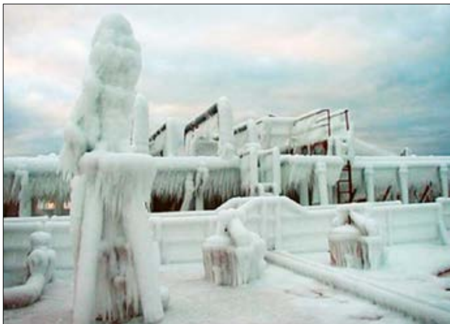
Ising skaper store problemer på skip og installasjoner.
