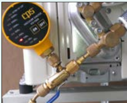
Bildet til venstre viser pågående vakuumering med åpen ventil. Til høyre (holdetid) er ventilen stengt, og antall forbindelser mellom vakuummeter og kuldeanlegg er redusert til et minimum.
