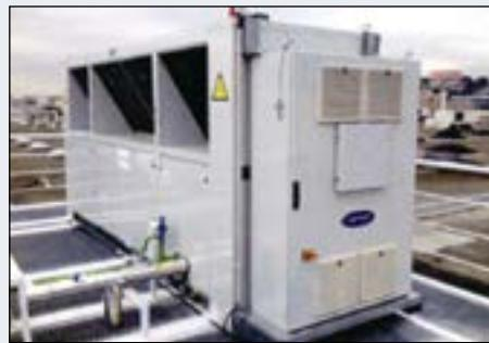
*Carriers hydrocarbon underkjøler på taket av et supermarked.*
