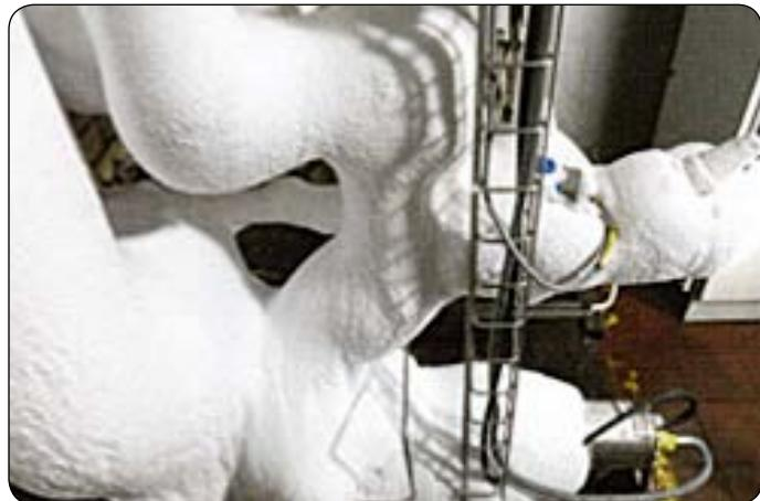
*Grundfos RC-pumpe i drift. Kun motordelen er synlig, da resten er pakket inde i is.*
