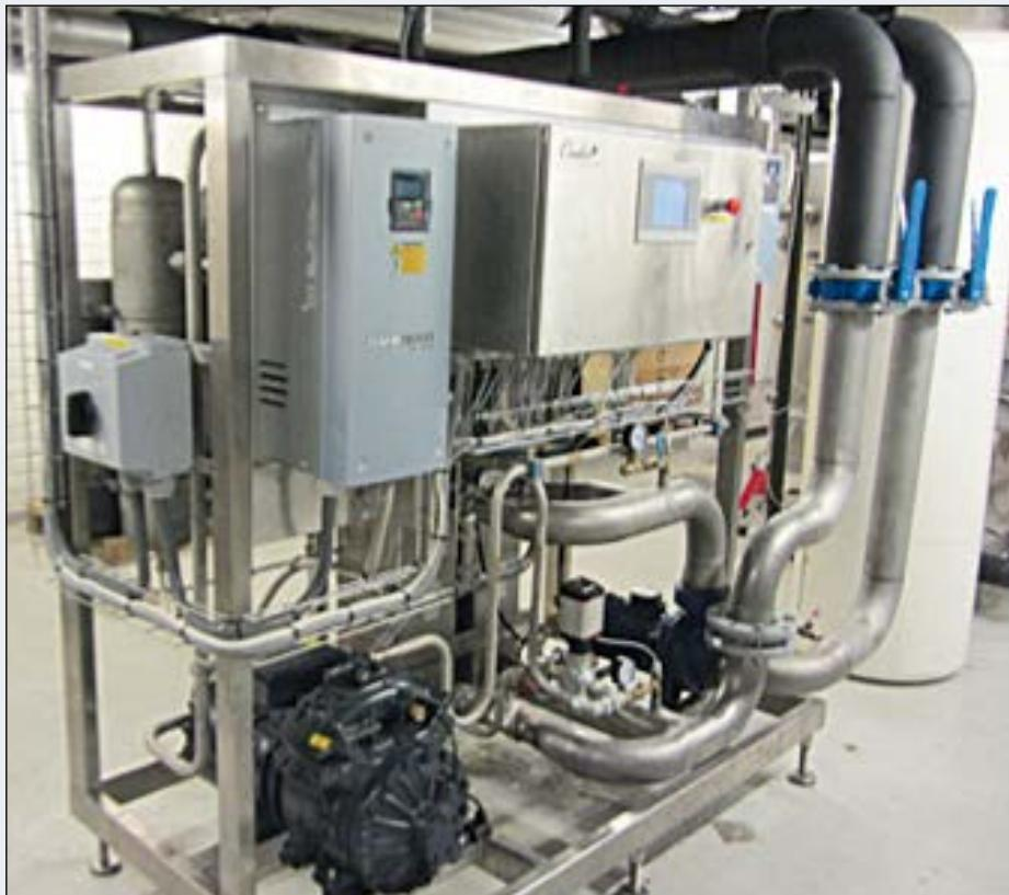
Figur 2  $\text{CO}_2$ -varmepumpen på Tine
