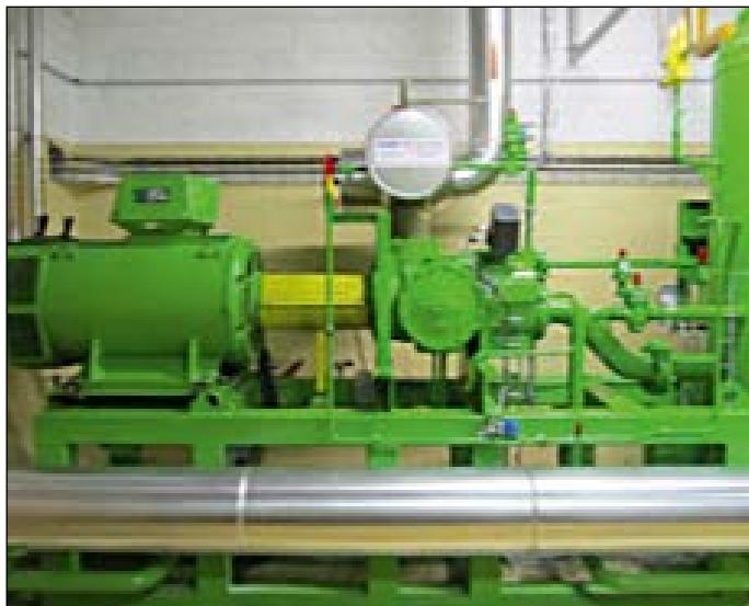
*Fire stempel kjølekompressorer ble byttet ut med en Vilter enkeltskru kompressor for både kjøling og oppvarming.*
