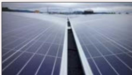
180 standardpaneler er montert på taket av Miljøhuset GK.
