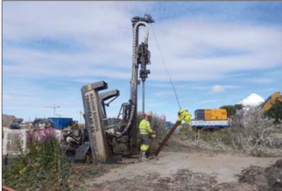
Båsum er godt i gang med boringen av de første brønnene. Brønnparken blir etablert i to faser, med 72 brønner i 2016 og ytterligere 72 brønner i 2018.
